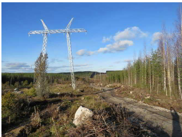
Kuva 15. Linjaus Kotajoen eteläpuolella, pohjoiseen.
