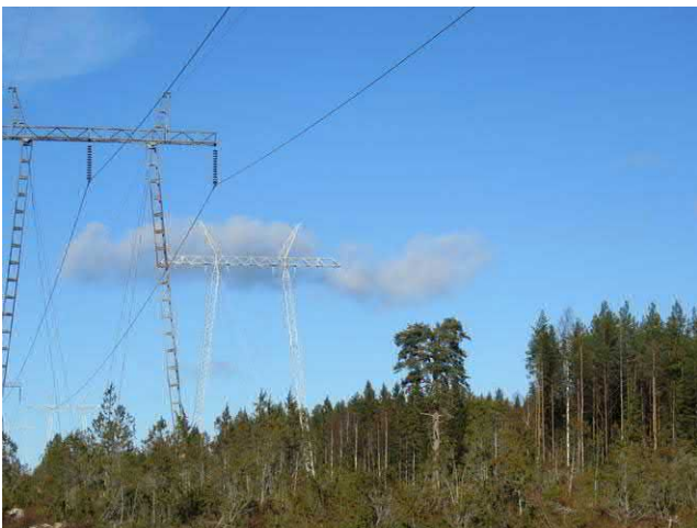
Kuva 3. Linjaus Kelkkamäen eteläpuolella, pohjoiseen.
