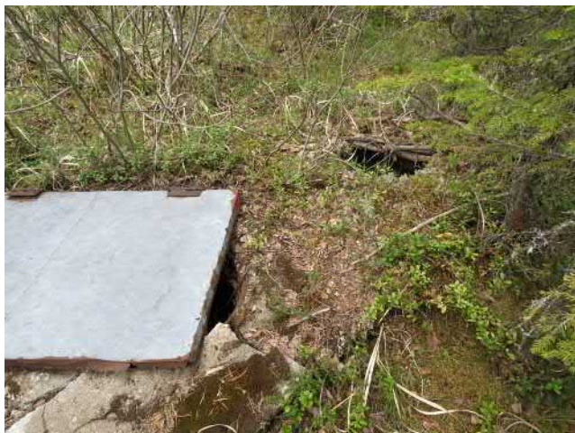
Kaivo (vain hatarasti peitetty &gt; vaarakohde)
