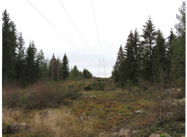
23. Johtolinjaus Järvimossenin pohjoispuolella.
