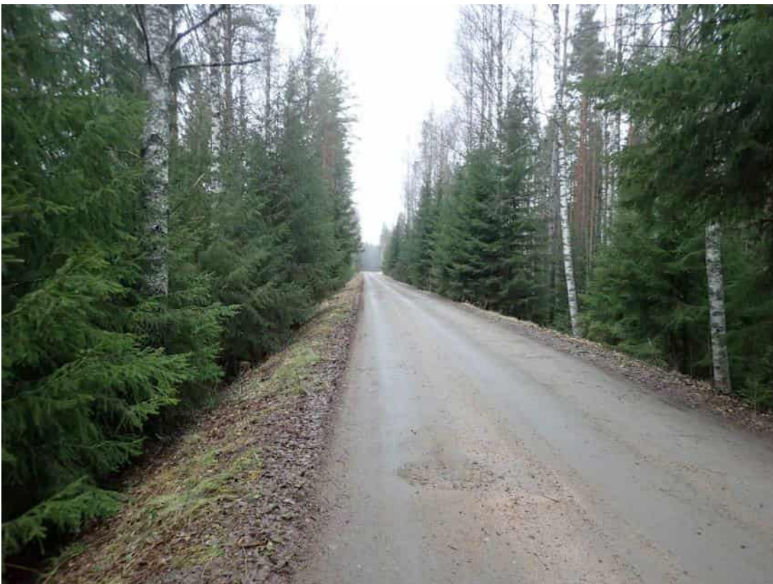
Kuva 42. Vanhaa ratapohjaa, nykyistä Ratapaanantietä. Pohjoiseen.
