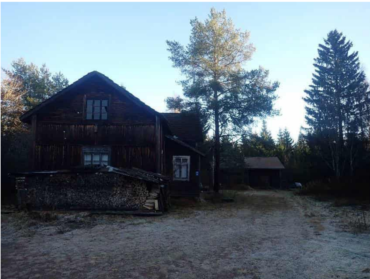
Kuva 4. Majamaan rakennuksia. Itään.
