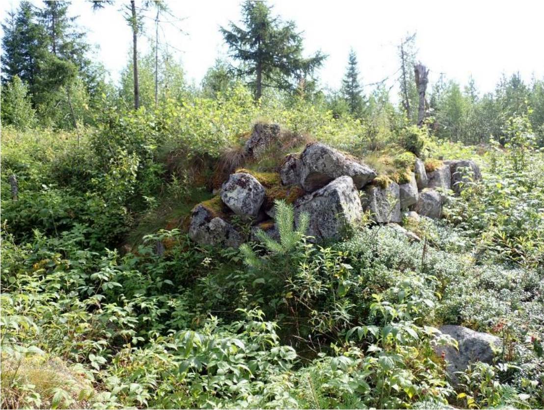
Kuva 3. Halssi on rakennettu kivistä kylmämuuraamalla. Itään.
