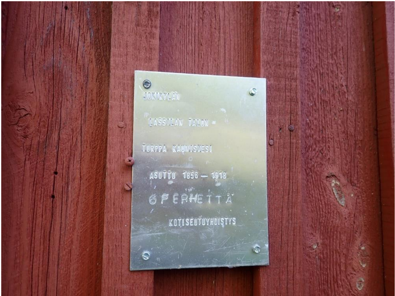
Kuva 70. Kaunisveden tien itäpuolella sijaitsevan rakennuksen seinässä oleva metallinen laatta. Koilliseen.
