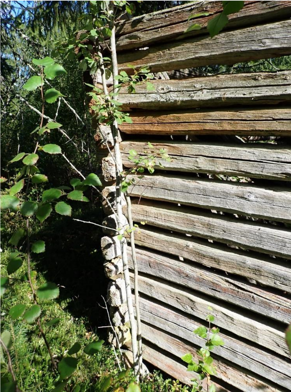
Kuva 8. Ladon hirret on numeroitu uudelleenrakentamista varten. Itään.
