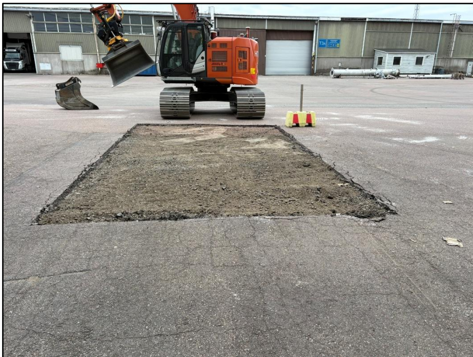
Näytteenottokuopan Af 4 paikka ennen kaivuutyön aloittamista. Kuvattu lounaaseen.
