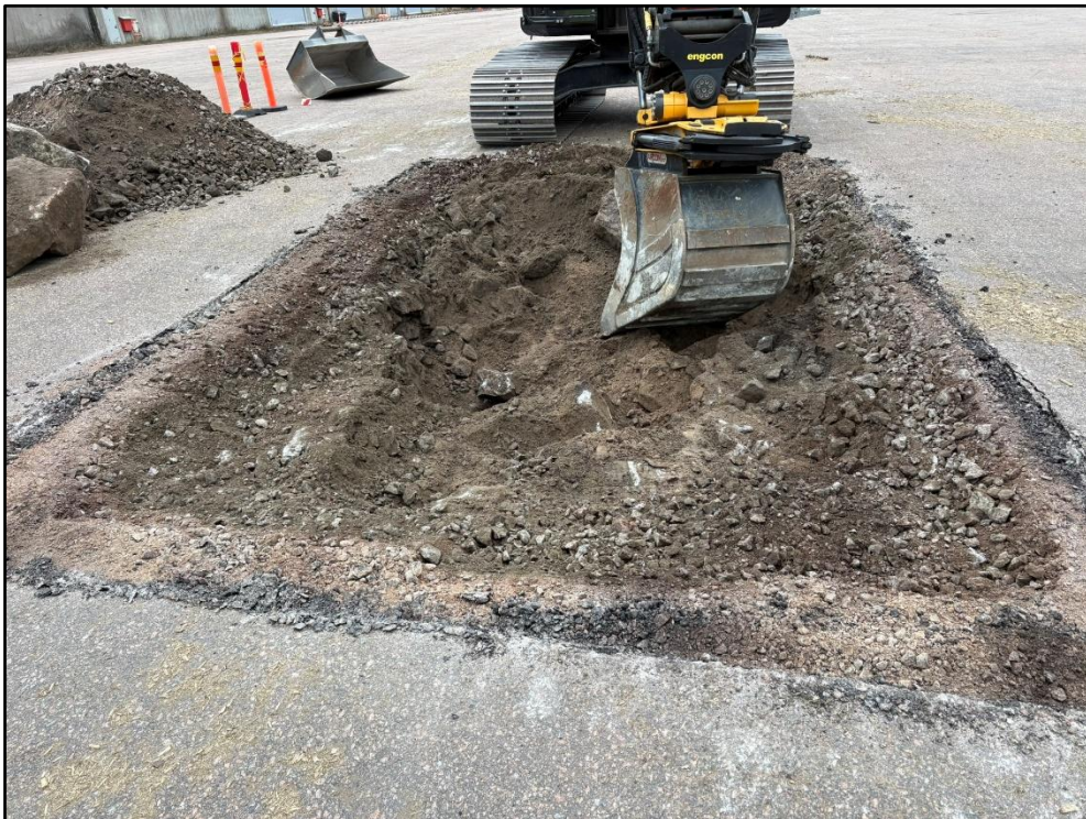
Näytteenottokuoppaa kaivetaan. Kuvattu pohjoiseen.
