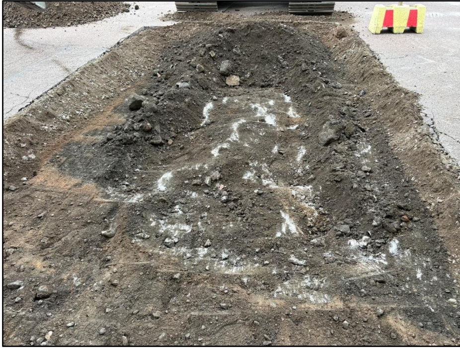
Näytteenottokuoppa kaivettuna peruskallioon saakka. Kuvattu lounaaseen.
