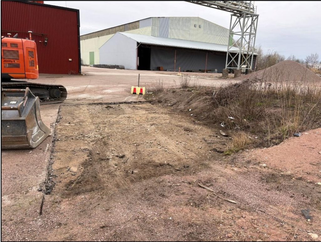
Kaivaminen aloitettiin hiekka- ja sepelipinnalta. Kuvattu koilliseen.
