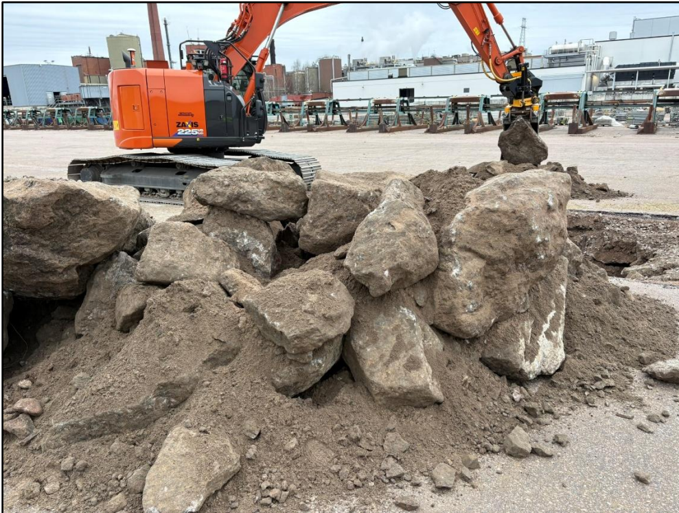
Kuopasta kaivettua louhetta. Kuvattu lounaaseen.
