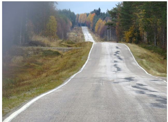
3. Hankealueen läpi kulkee Tannilantie, kuva etelään.
