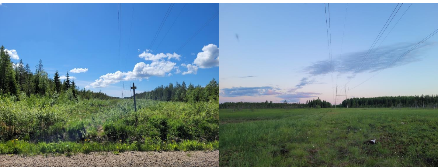
Kuva 27. Vanha voimalinja Lehmikummun tieltä etelään katsottuna.
