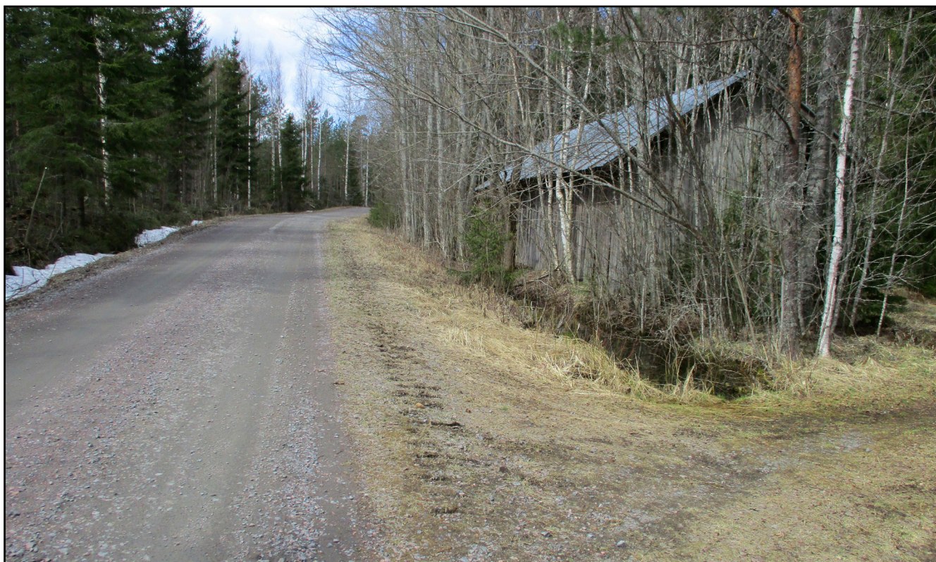
Kuva 14. Pihlavan torpan ulkorakennus Kevalavantien vieressä.
