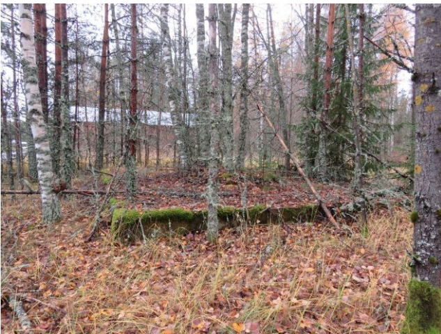
23. Luukkilan talon perustus etelään.
