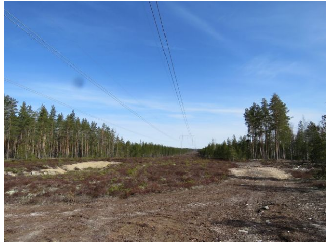
14. Voimalinja Rakennuskankaalla, koilliseen.
