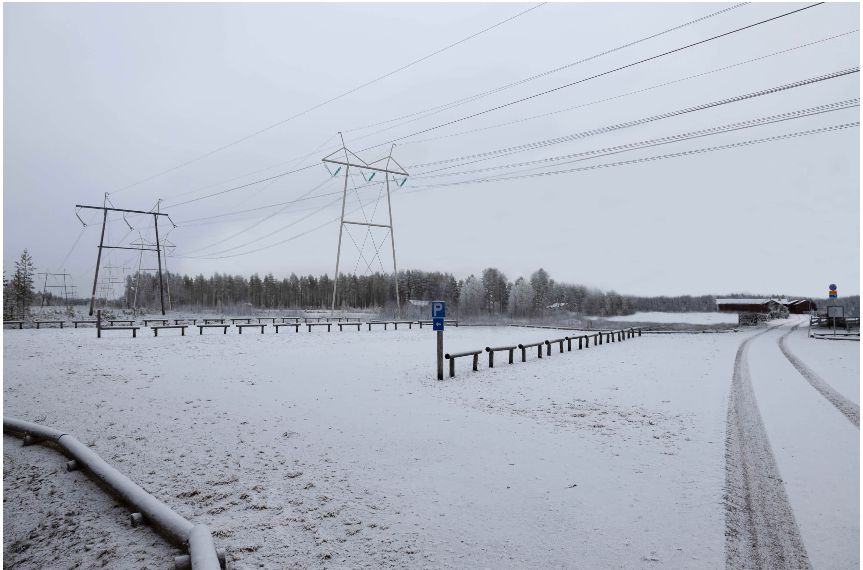
Kuva 178. Kuvauspiste 1. 400 kV voimajohdon kuvasovite kuvauspisteestä 1 (Lamminaho)
