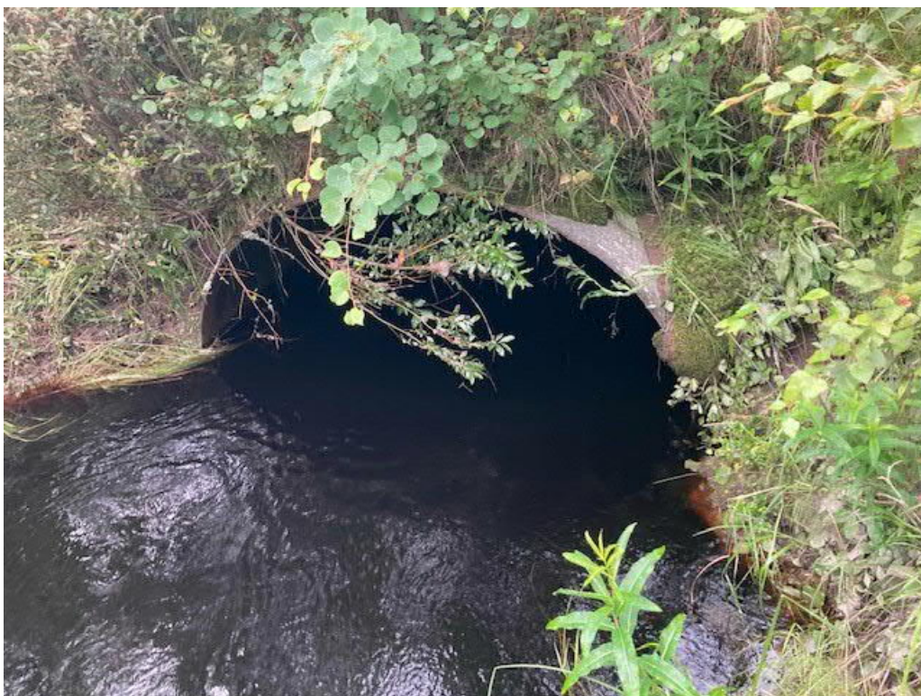
Poikkijoki, metsäuran metallinen siltarumpu, ei nousuestettä
