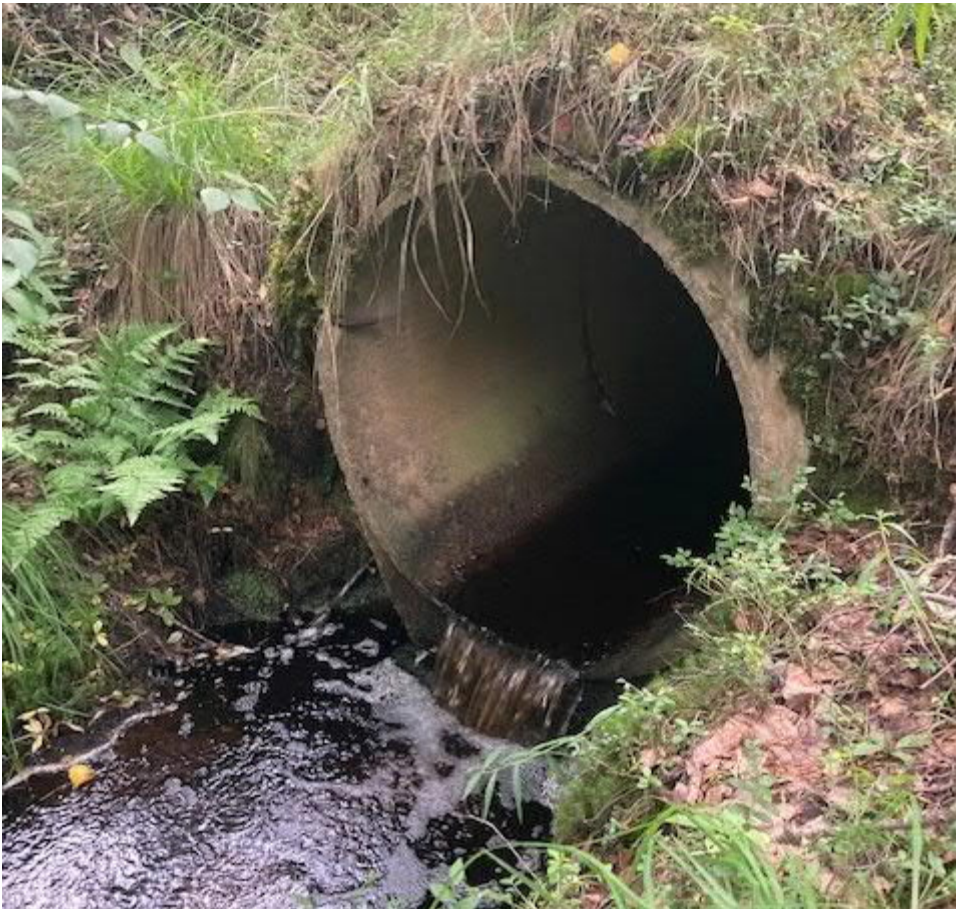
Pyypuro, tiesillan betonirumpu, todennäköinen nousueste suurimman osan vuodesta
