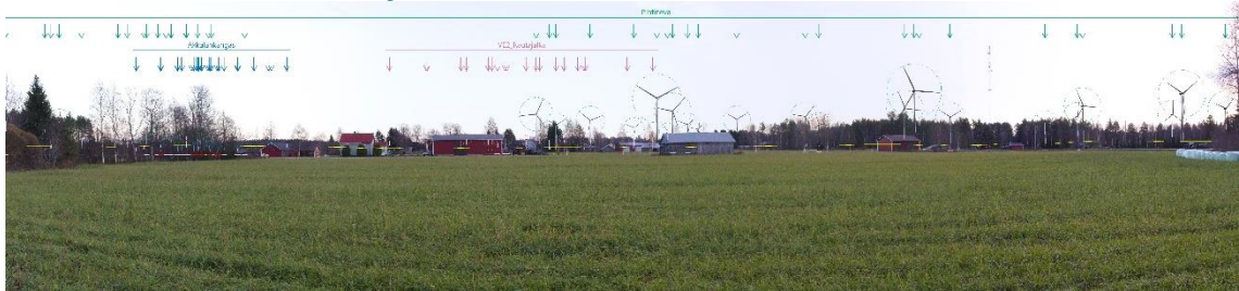
Kuva 46. Valokuvasovite Välikylästä (11), Rautajalan tuulivoimalat VE2. Etäisyyttä kuvauspisteeltä lähimmälle Rautajalan voimalalle on noin 11 kilometriä. Kuva on otettu 35 mm objektiivilla, koska kamera ei ole täyskenno/kinokoon kamera.
