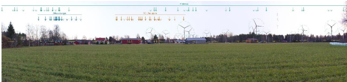
Kuva 45. Valokuvasovite Välikylästä (11), Rautajalan tuulivoimalat VE1. Etäisyyttä kuvauspisteeltä lähimmälle Rautajalan voimalalle on noin 11 kilometriä. Kuva on otettu 35 mm objektiivilla, koska kamera ei ole täyskenno/kinokoon kamera.
