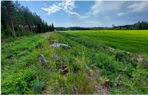
Kuva 2-1. Ajopolku, penger ja pelto uuden tien rakentamisalueella kuvattuna pengermän päältä.
