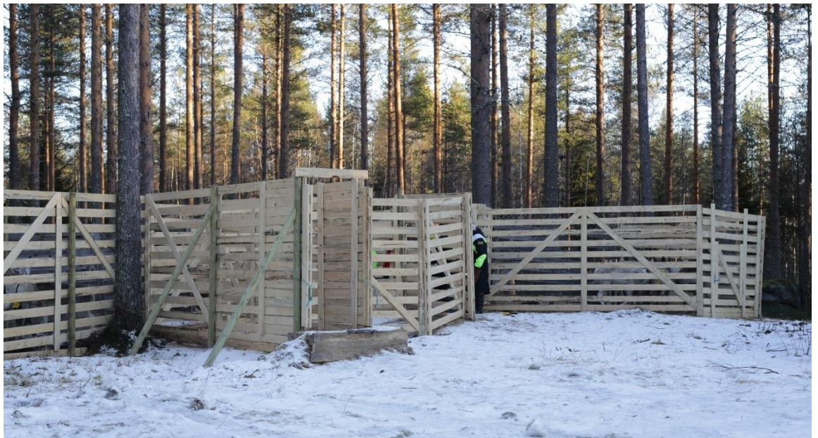
Kuva 2-12. Korpelan erotusaita, Simossa. Kuva: Sitowise 31.10.2024.
