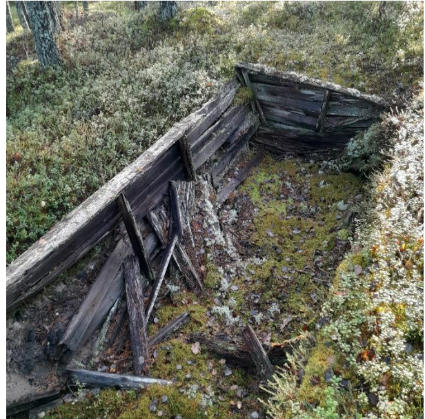
Kuva 13. Järvenpään tervahauta 1:n lautarakenne. Kuva: Taneli Leinonen.
