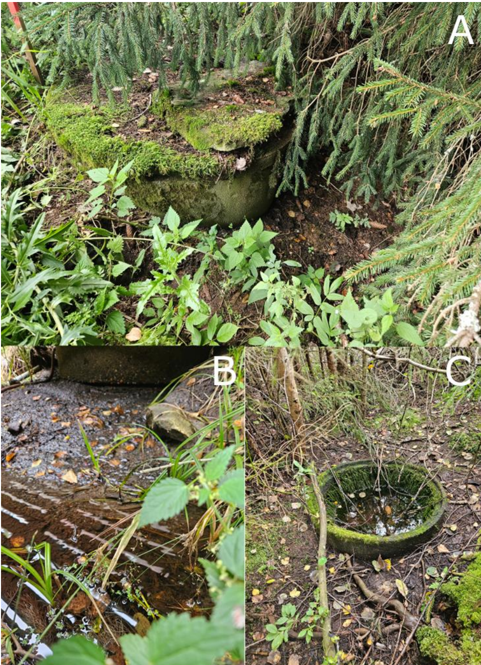
Kuva 7 Kaivokohteet A=kohde 2, joka oli täysin umpinainen kaivorakenne. B=kohde 3, jonka alareunasta valui pohjavettä ojaan ja C=kohde 4, joka on kaivorakenteella tuhottu lähde.
