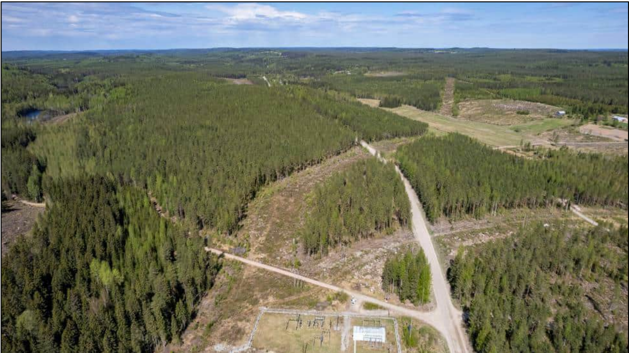
Kuva 4. AKDG7430:22. Sähkönsiirtoreitin eteläpää Vesannon kirkonkylän pohjoispuolella. Sähköasema kuvan alalaidassa. Kuvauskopterin kuva etelästä.
