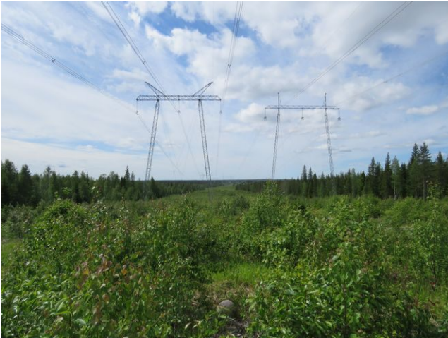
Kuva 41. Lautamaan kohdalla linjakäytävään yhtyi toinen voimalinja lounaasta.
