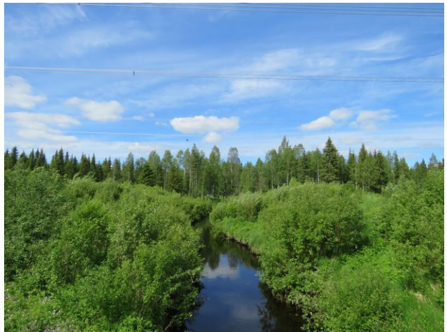
Kuva 44. Linja Leivejoen kohdalla, kuvattu pohjoiseen.
