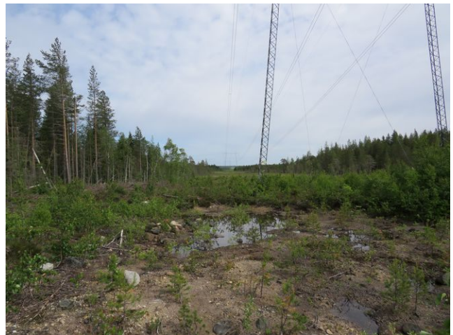
Kuva 26. Voimalinja Yhteisenlehdosta, kuvattu itään.
