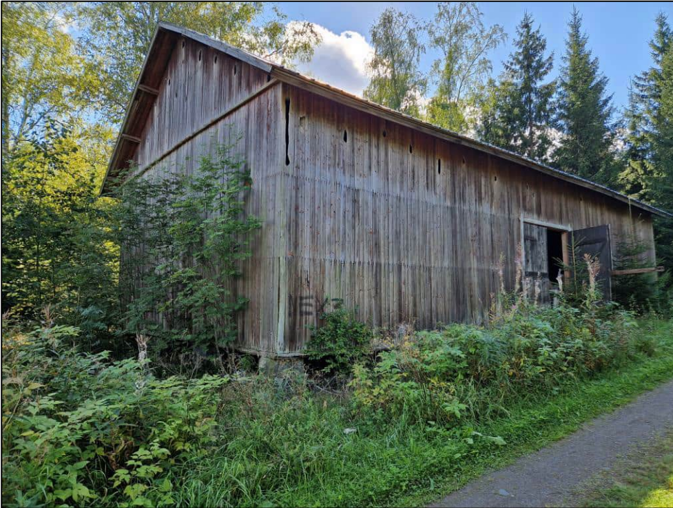
Kuva 5. Sisätilaselvityksessä tarkastettu lato. Kuvaussuunta etelään.
