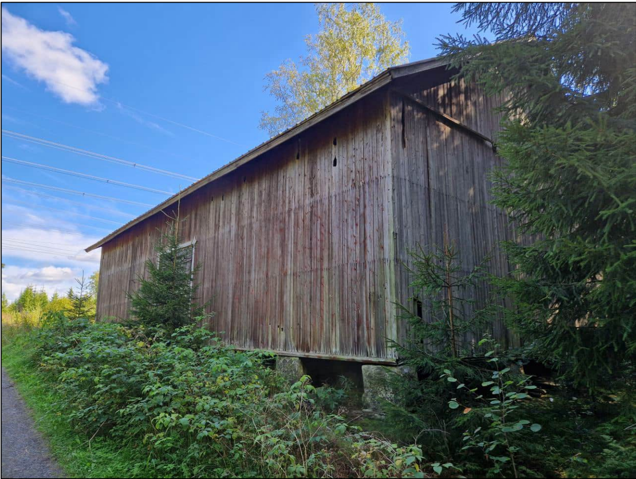
Kuva 4. Sisätilaselvityksessä tarkastettu lato. Kuvaussuunta koilliseen.
