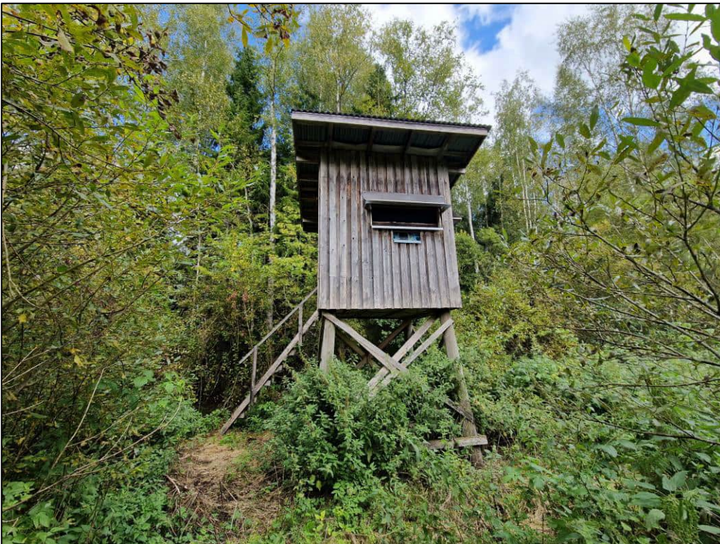
Kuva 8. Sisätilaselvityksessä tarkastettu metsästyskoppa.
