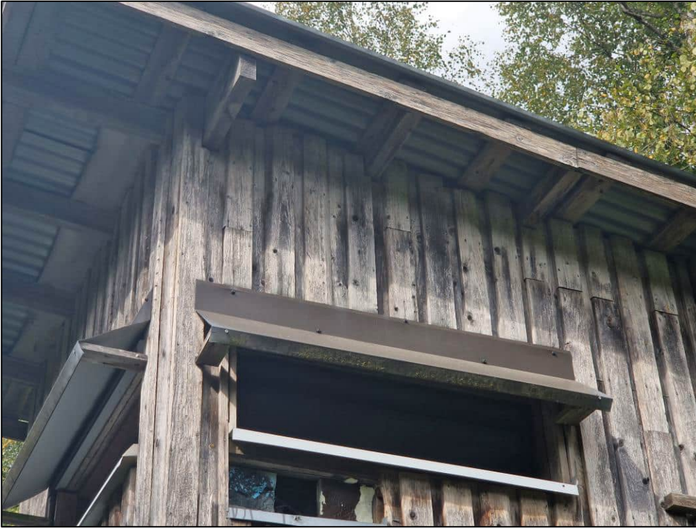
Kuva 9. Metsästyskopin kattorakenteita ulkopuolelta.
