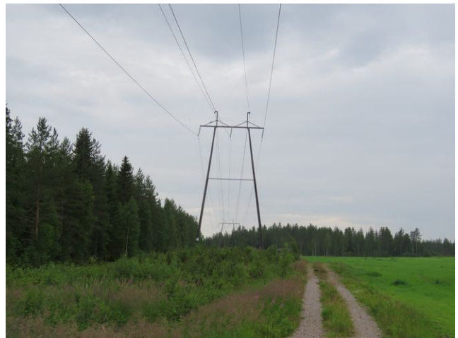
Kuva 25. Voimalinja Krjokorven pellon kohdalla.
