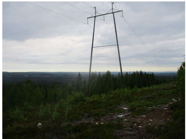
Kuva 21. Voimalinja hankealueen eteläpuolella, luoteeseen.
