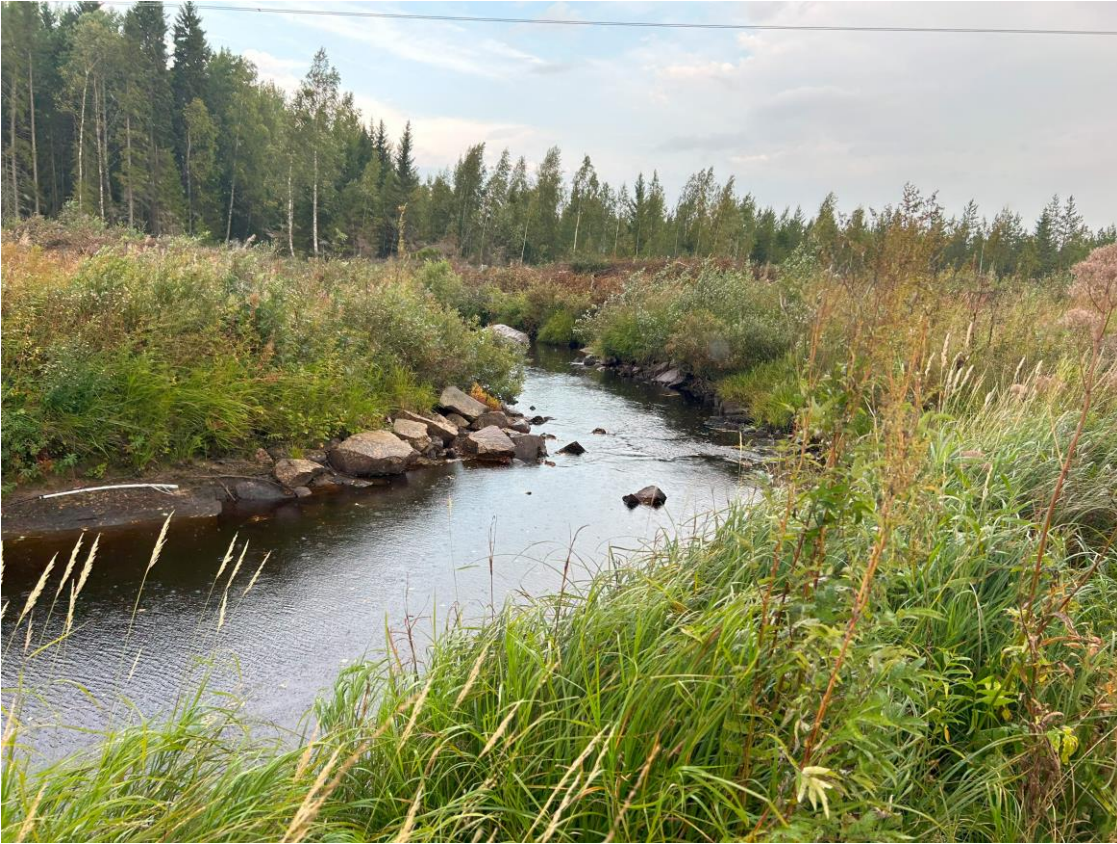
Kuva 12. Liminganojan uoma eteläpuolelta kuvattuna (kohde 3). Kuvaussuunta luoteeseen.
