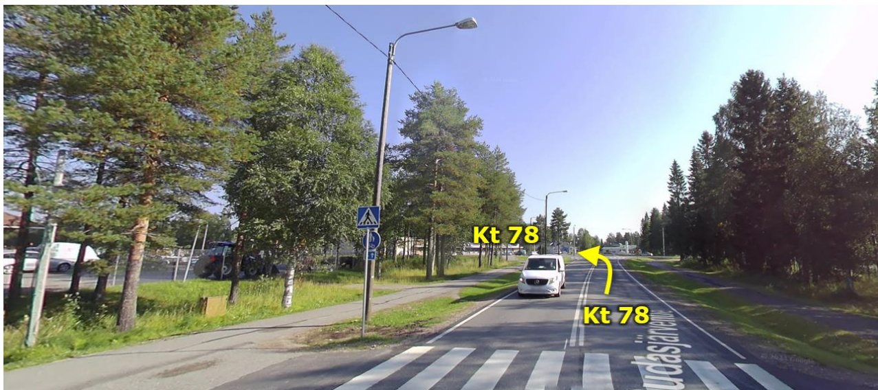
Kuva 13: Kantatiellä 78 Ranualla rakennuksia on lähellä liittymää (Google Maps 2024).
