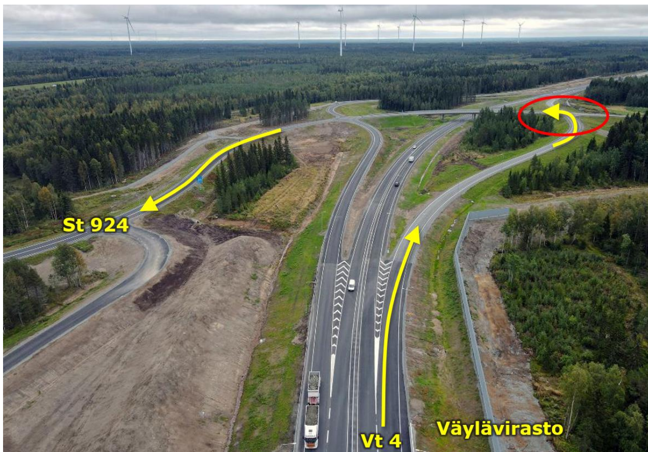
Kuva 9: Valtatie 4 ja seututien 924 eritasoliittymä Simossa (Väylävirasto 2024).
