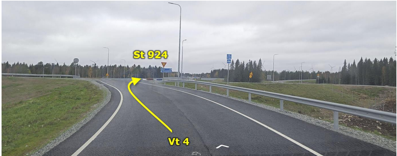
Kuva 14: Valtatien 4 ja seututien 924 eritasoliittymä etelän suunnasta tultaessa (Google Maps 2024).
