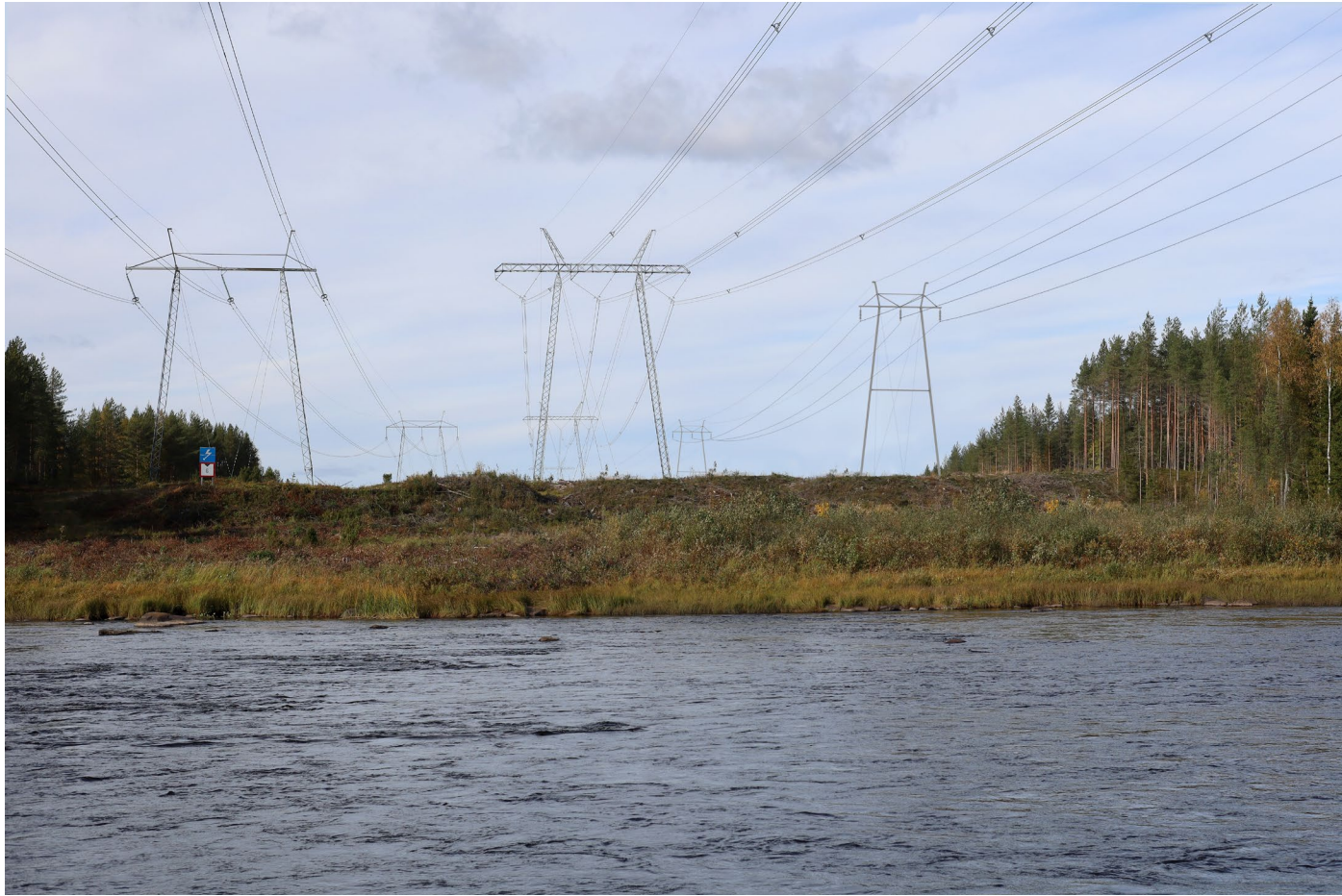
Kuvauspaikka 9 SVE1 Ranuantie 53 kohdalta Simojoen rannasta. Suunniteltu 110 kV voimalinja oikealla. Kuvattu 50 mm polttovälillä.
