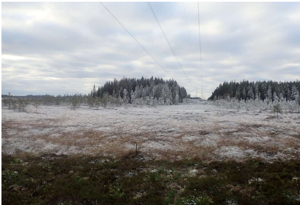
Kuva 15. Uutta linjaa suunnitellaan kohdalla vanhan oikealle puolen. Lapiion kohdalla rajamerkki (kohde 10). Kuva: Arttu Tokoi.
