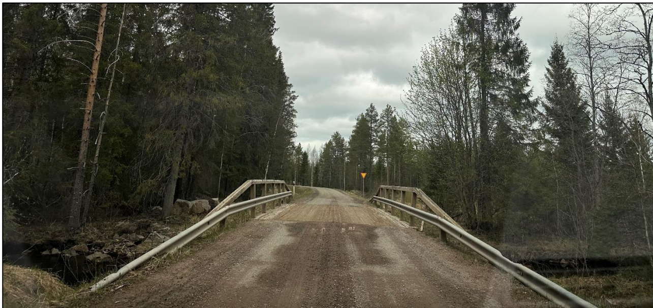
Kuva 5: Liminganojan silta yhdystiellä 18241.
