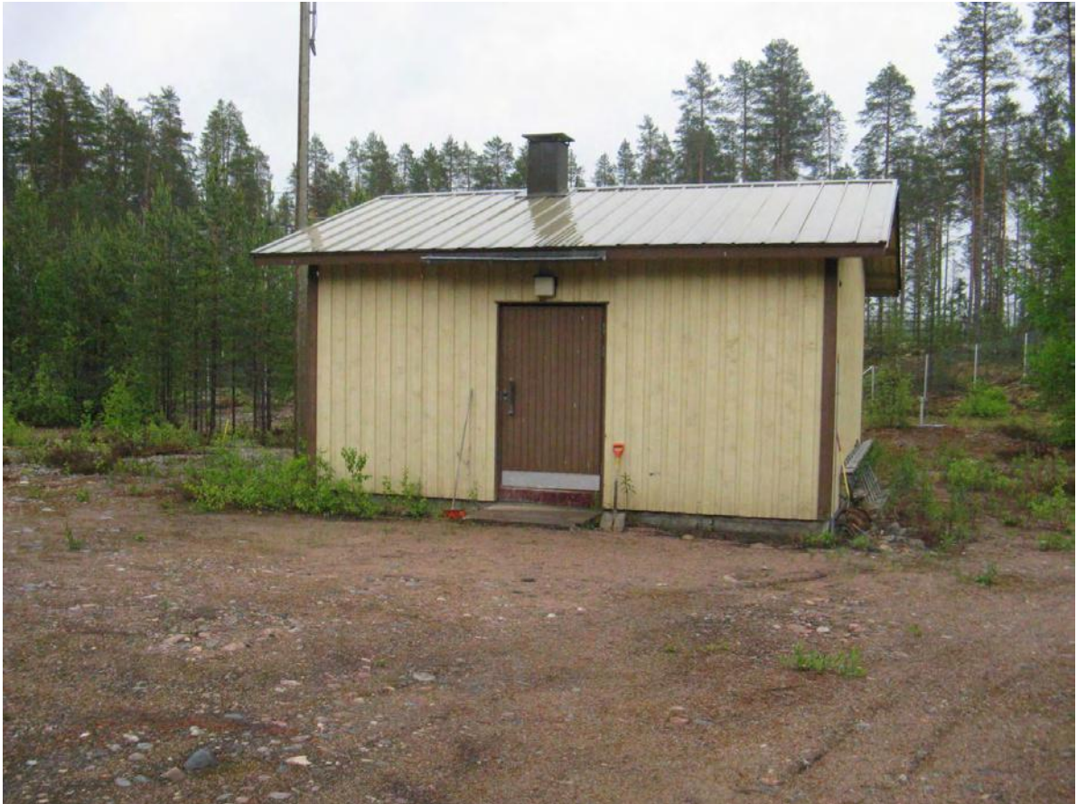
Kuva 3. Kapustakankaan vedenottamo on Puolangan kunnan päävedenottamo
