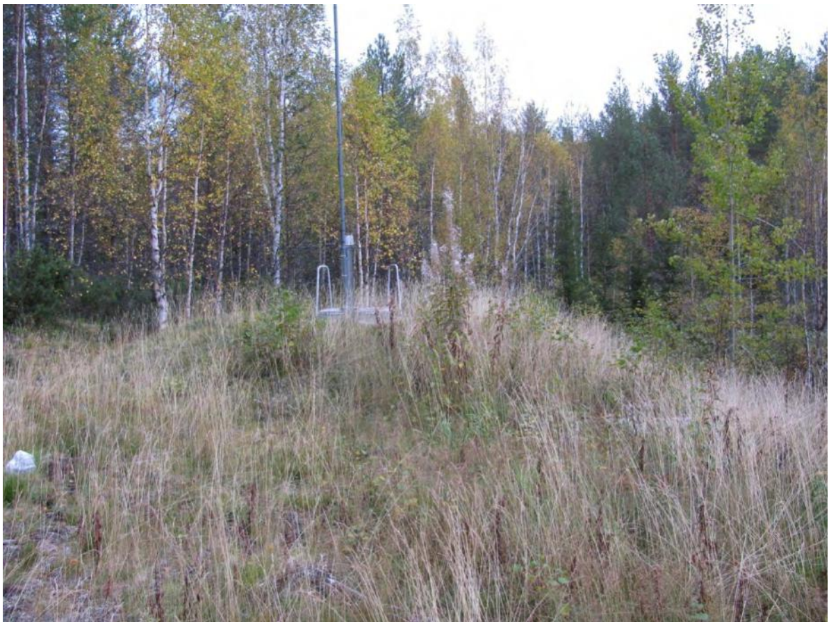
Kuva 4. Kotilan vedenottamo Rakennuskankaan pohjavesialueella.
