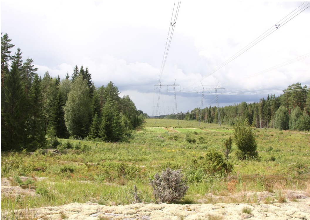
V2. Kevalankallion kohdalla linjaus kulkee kalliomaastossa
