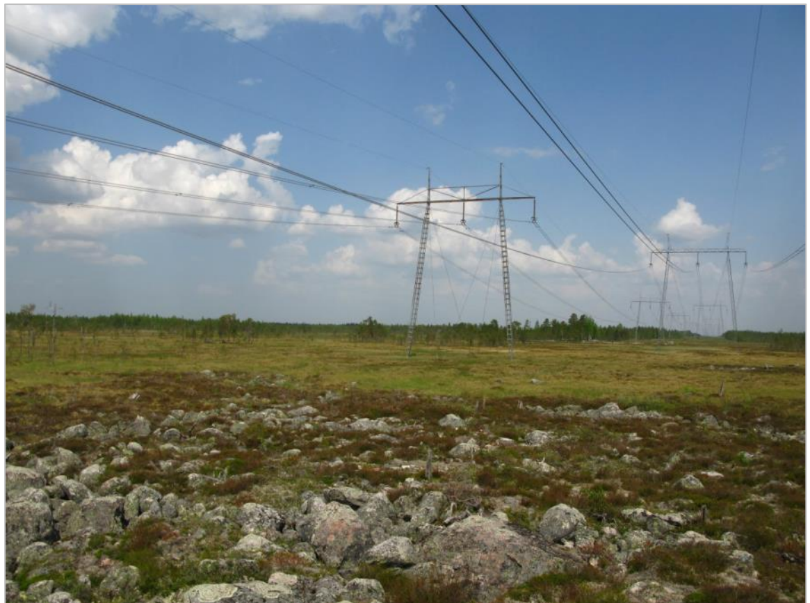
Kuva 17. Nykyiset 2x400 kV voimajohdot katajajärvennevalla.
