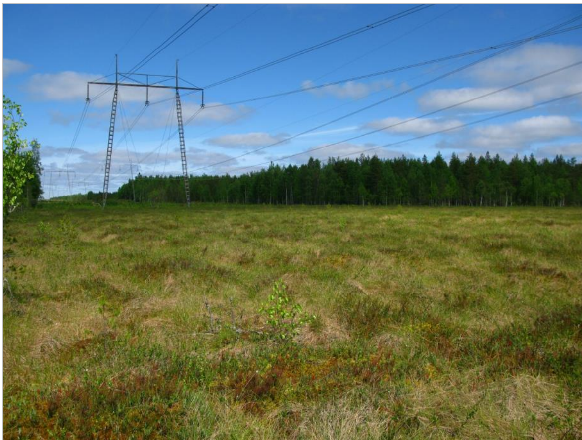
Kuva 28. Muurausnevaa suunnitellun voimajohdon kohdalla
