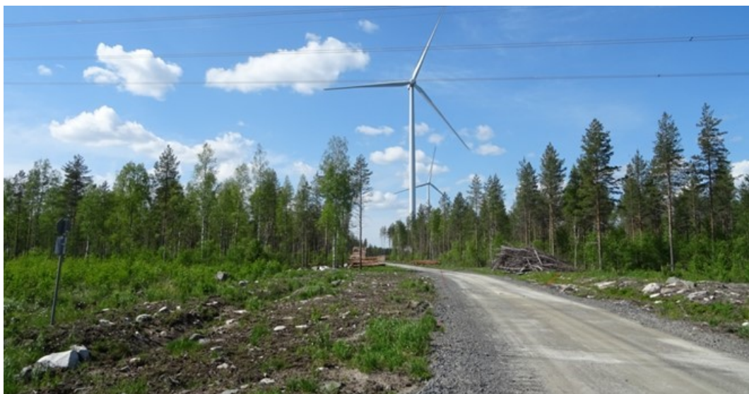
Kuva 11. Esimerkki tuulivoimapuiston rakennus- ja huoltotiestä. Maakaapelin oja on sijoitettu tien vasemmalle puolelle. Teitä käytetään muun muassa betonin ja soran sekä voimaloiden komponenttien kuljetuksiin. Tuulivoimapuiston käyttövaiheessa teitä käytetään mm. vuosittaisissa huolloissa.
