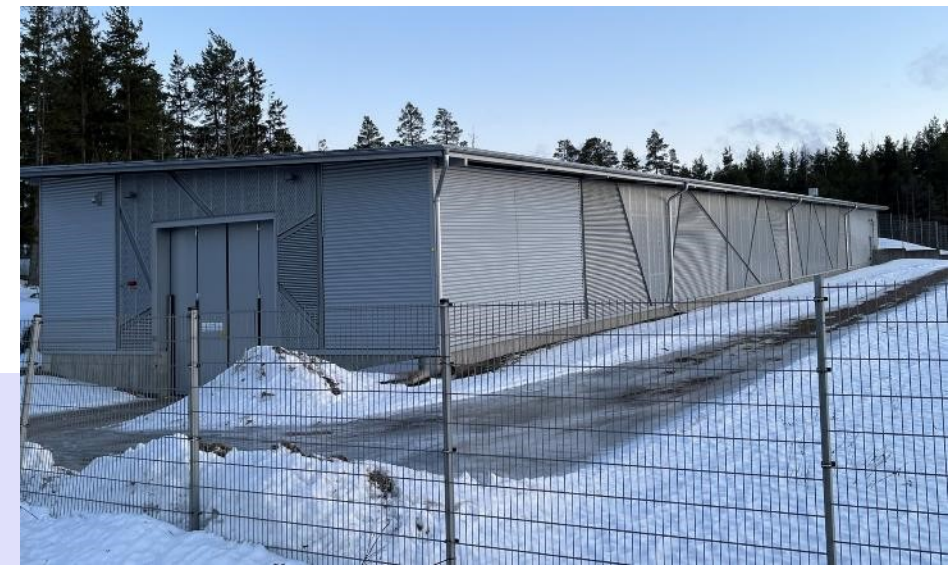
Kuva: Esimerkki ajotunnelin rakennuksesta
