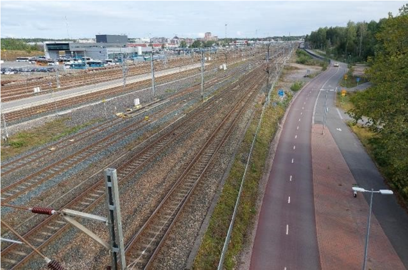
Kuva: Pasilan / Ilmalan ratapiha Hakamäentien sillalta kuvattuna.
