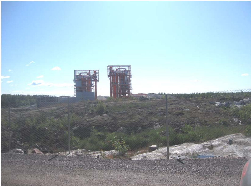
Kuva 7-13. Näkymä lännestä kohti hankealuetta. Kuvassa näkyy hankealueella vielä olevaa louhittavaa kallioaluetta
