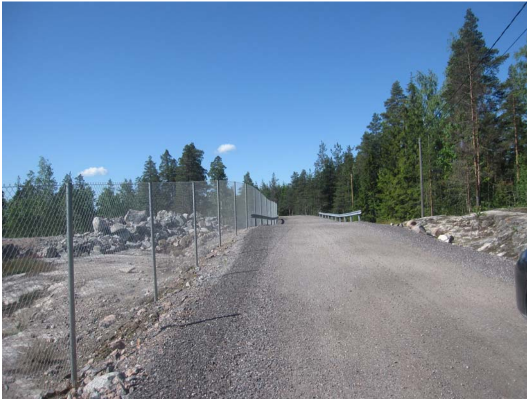
Kuva 7-14. Näkymä hankealueen länsirajalla kulkevaa Ruohosuontietä pitkin kohti etelää. Osa hankealueelta vielä louhittavasta kallioalueesta näkyy kuvassa vasemmalla.
