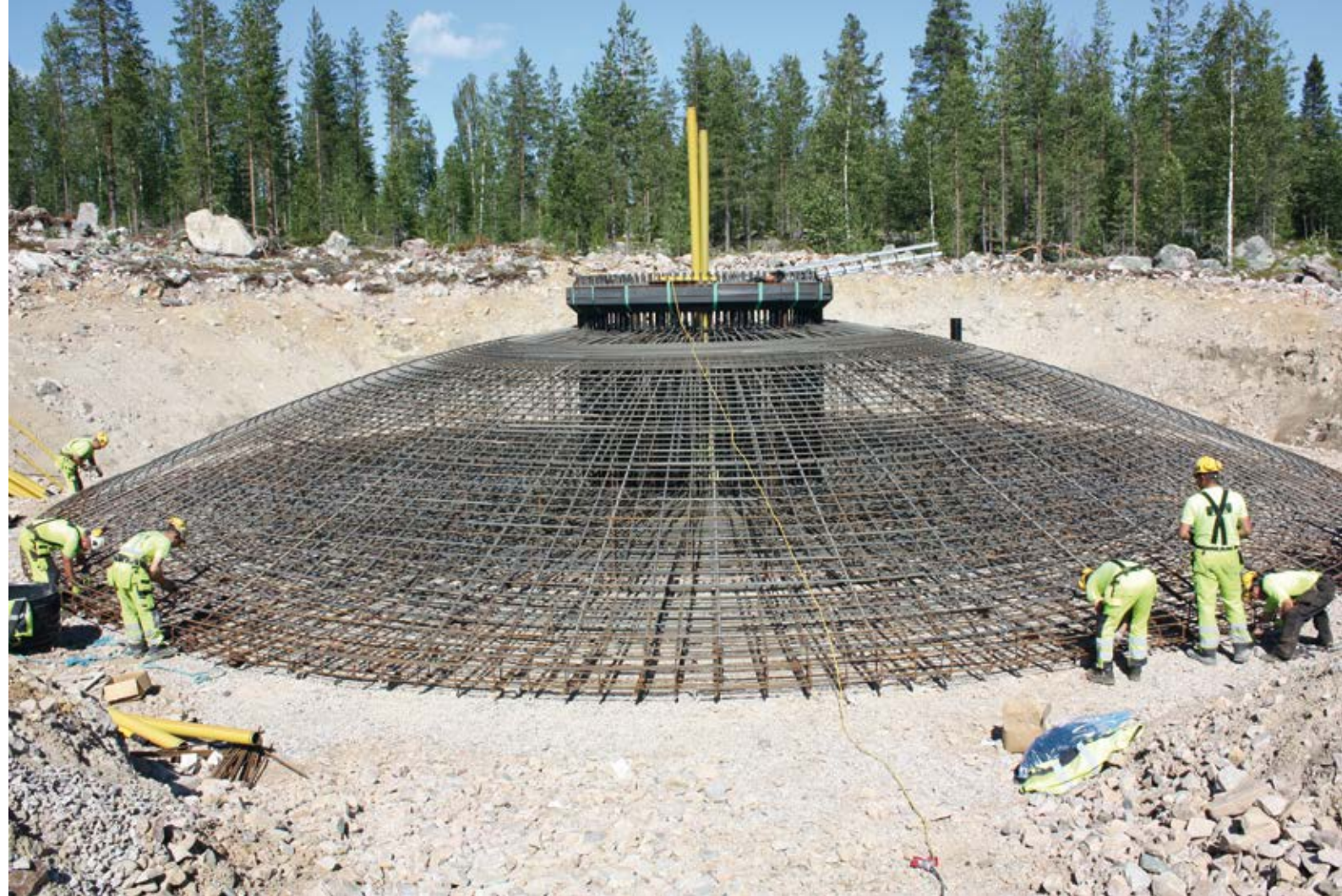
Kuva 3-8. Maanvarainen teräsbetoniperustus raudoitettuna ennen betonivalua, Tervola.
