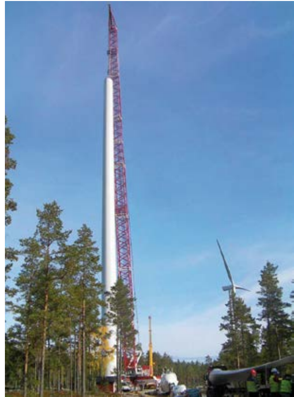
Kuva 3-24. Tuulivoimalan pystytys (Nordisk Vindkraft Oy).
