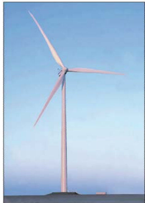
Kuva 3-5. Periaatekuva lieriötornirakenteisesta tuulivoimalasta.
