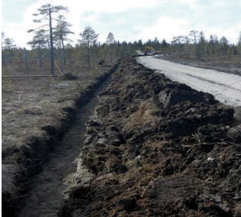
Kuva 3-14. Maakaapelit sijoitetaan ensisijaisesti huoltoteiden yhteyteen (Nordisk Vindkraft Oy).
