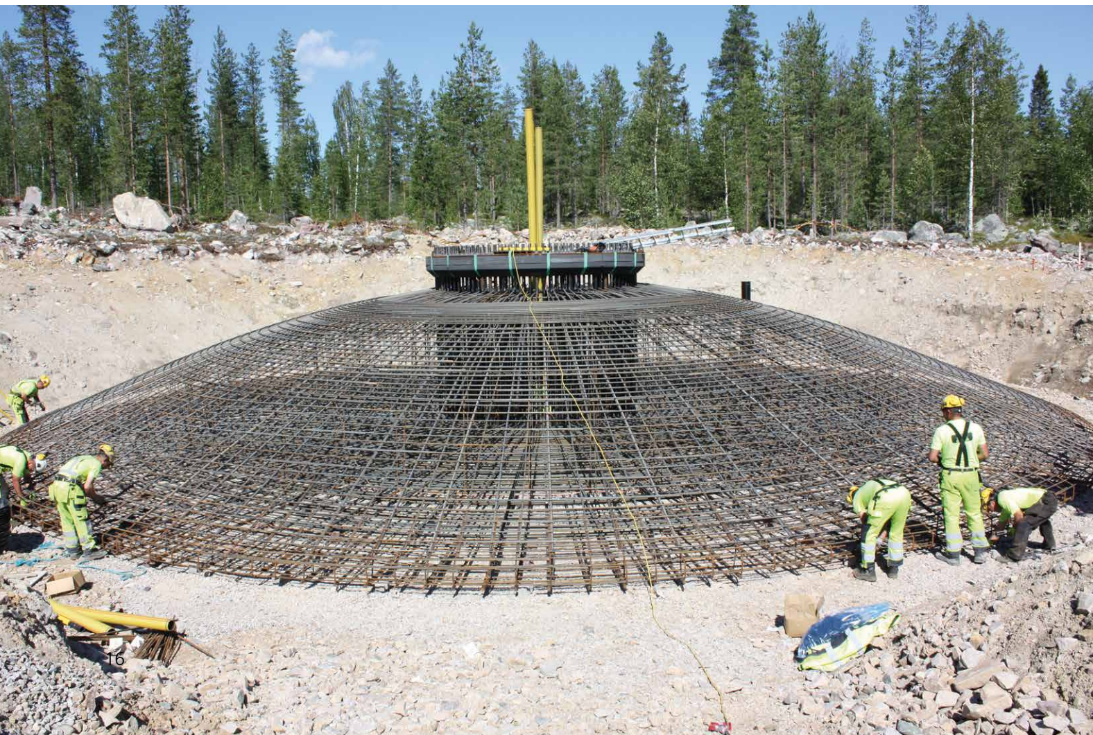
Kuva 4-5. Maanvarainen teräsbetoniperustus raudoitettuna ennen betonivalua.
