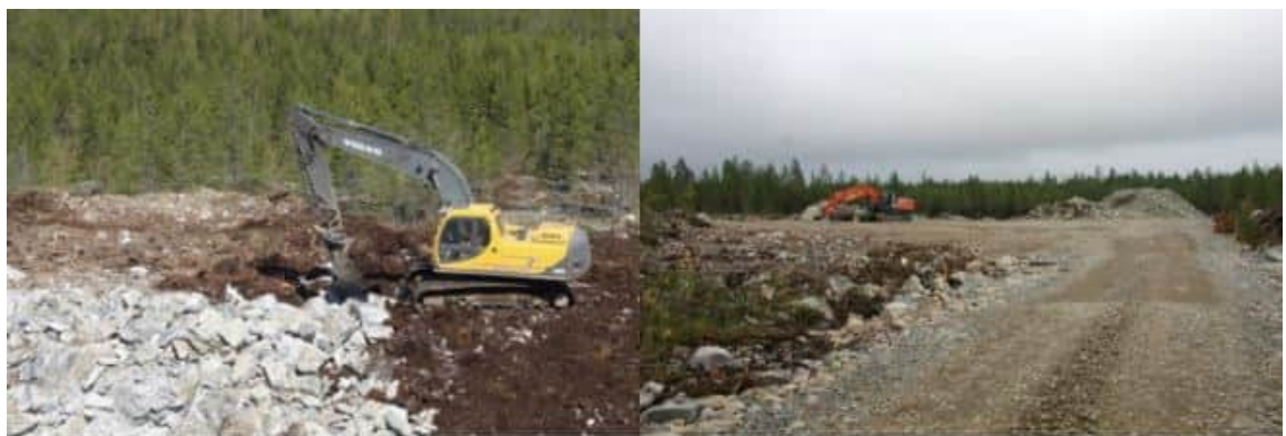
Bild 4.11. Byggandet av vindkraftsparken inleds med att bygga vägar och lyftområden. (bilder: FCG).
