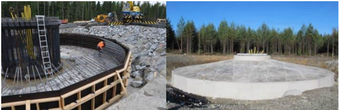
Bild 4.13. Byggande av vindkraftverkens fundament (Bilder: FCG).
