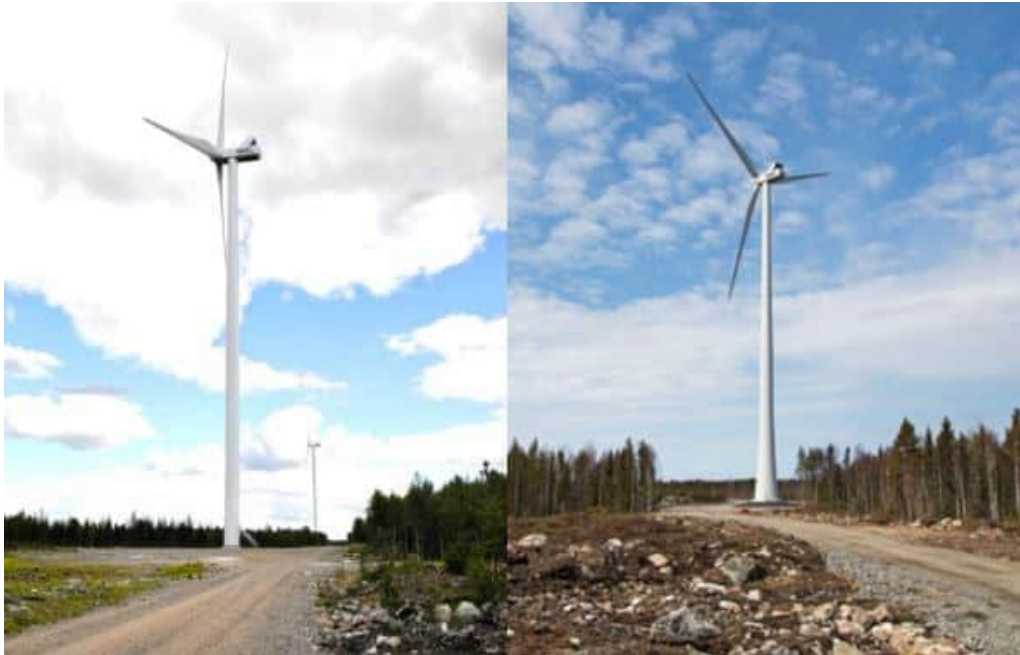
Bild 4.2. Till vänster ett exempel på ett stålcylindertorn och till höger ett hybridtorn (Bilder: Leila Väyrynen, FCG).
