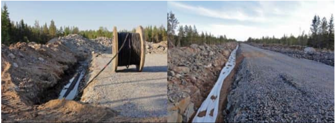
Bild 4.12. Jordkablarna grävs ner i anslutning till servicevägarna (Bilder: FCG).
