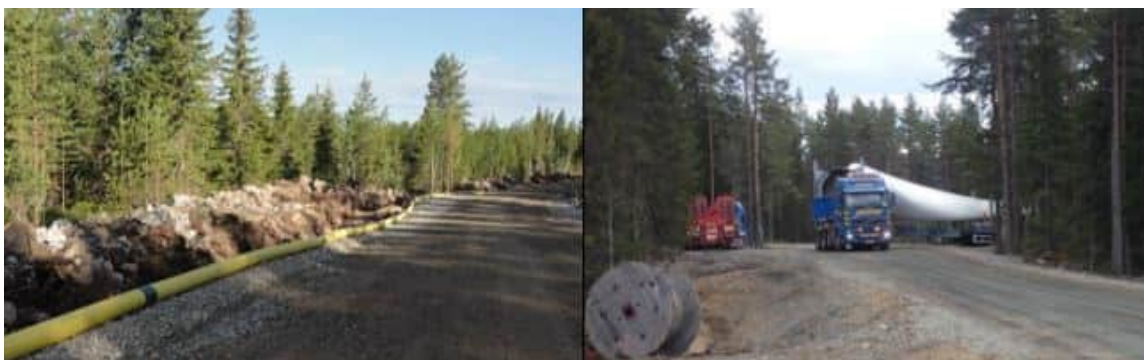
Bild 4.8. Till vänster ett exempel på byggnads- och servicevägar i en vindkraftspark. Vägar används bland annat för transport av betong, grus och kraftverkskomponenter samt för servicekörningar i vindkraftsparkens driftsskede. Jordkabeln placeras i ett dikschakt i kanten av vägen. Till höger delar till vindkraftverk som transporteras som specialtransporter. (Bilder: FCG).
