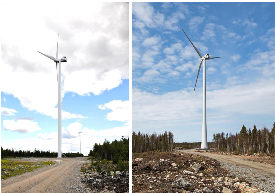
Bild 11. Till vänster ett exempel på ett stålcyklindertorn och till höger ett hybridtorn. (Bilder: Leila Väyrynen och Ville Suorsa, FCG)
