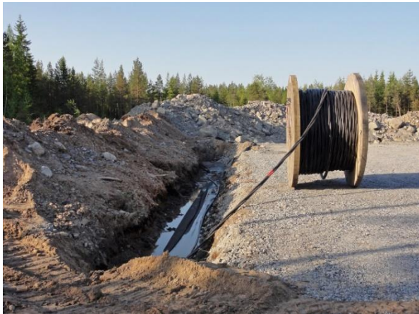
a 14 Jordkablarna sänks i anslutning till servicevägarna (bilder: Ville Suorsa/FCG).
