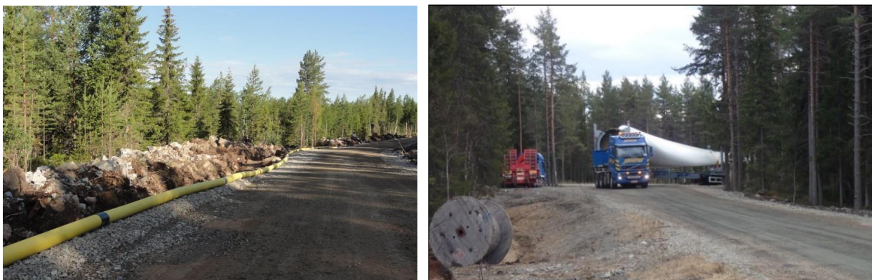
Figur 14. (Till vänster) Ett exempel på vindkraftsparkens byggnads- och servicevägarsimerkki. Vägarna används bl.a. till att transportera betong, grus och kraftverkskomponenter till vindkraftsparken i bruksskedet. Jordkabeln placeras i det grävda diket vid vägens randområde. (Till höger) Vindkraftverkets delar transporteras med specialtransporter. (Bilder: Ville Suorsa / FCG).
