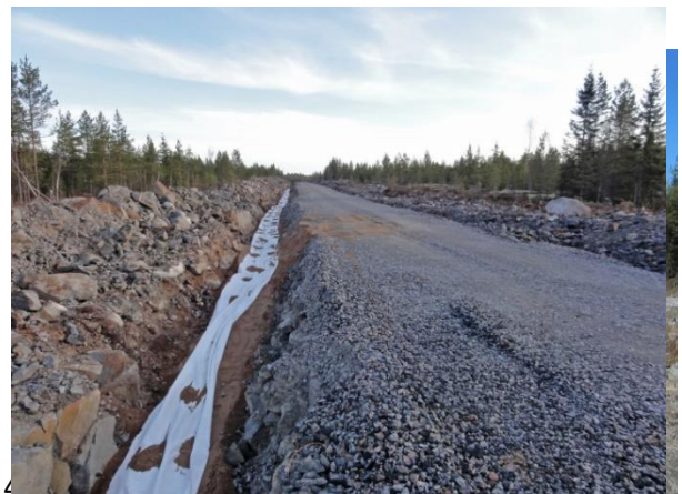
a 14 Jordkablarna sänks i anslutning till servicevägarna (bilder: Ville Suorsa/FCG).
