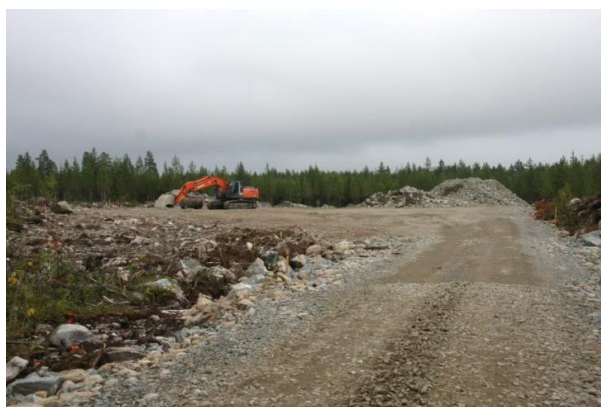
Bild 16. Byggnad av en vindkraftspark påbörjas genom att bygga vägar och service-/resningsområden (bilder: Ville Suorsa, FCG).
