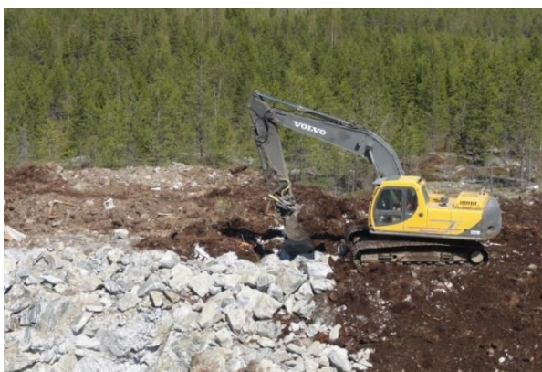
Bild 16. Byggnad av en vindkraftspark påbörjas genom att bygga vägar och service-/resningsområden (bilder: Ville Suorsa, FCG).
