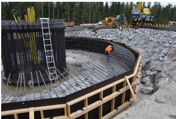
Bild 17. Byggande av vindkraftverkets fundament. (Bilder: Leila Väyrynen, FCG)
