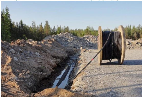
Kuvapari 4-15. Maakaapelit upotetaan huoltoteiden yhteyteen (kuvat: FCG).
