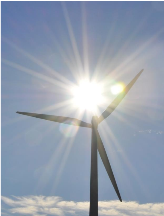
Kuva 17-18. Tuulivoimaloiden lavat aiheuttavat pyöriessään varjon vilkkumista aurinkoisella säällä.
