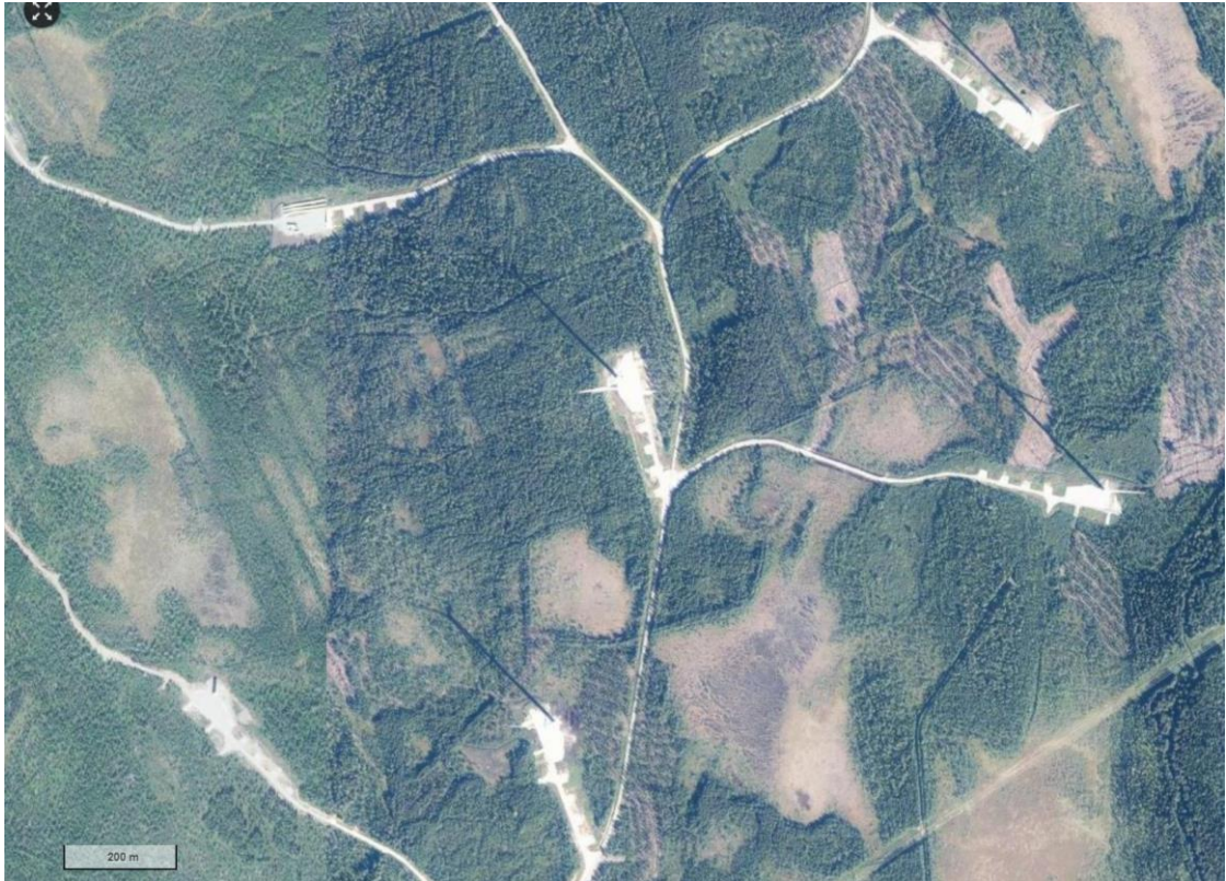
Kuva 4-1. Sarvisuon (Simo) tuulivoimaloiden rakentamisaikaa ilmakuvassa. Kuvan oikeassa reunassa ja keskellä on jo toiminnassa olevia tuulivoimaloita, vasemman reunan voimalat ovat rakenteilla. Huoltotiet ja nostokentät on jo rakennettu. Tuulivoimaloiden ympäristössä ja välialueilla aikaisempi maankäyttö on säilynyt ennallaan. (Ortokuva: Maanmittauslaitos, kuvattu 2023)
