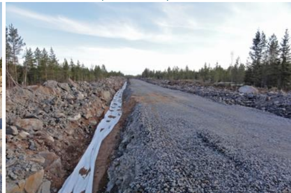
Kuvapari 4-15. Maakaapelit upotetaan huoltoteiden yhteyteen (kuvat: FCG).
