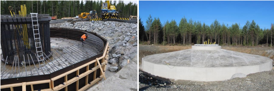
Kuvapari 4-16. Tuulivoimalan perustusten rakentamista. (Kuvat: Leila Väyrynen, FCG)
