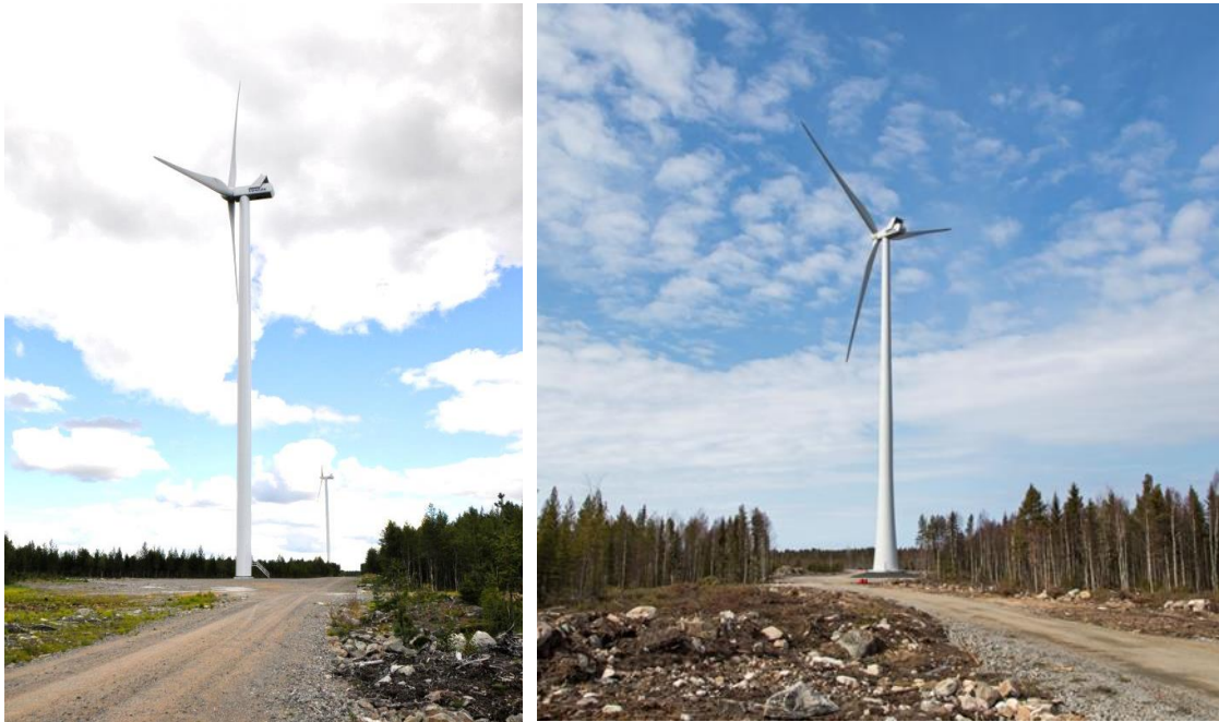
Kuva 4-2. Vasemmalla esimerkki teräslieriötornista ja oikealla hybriditornista. (FCG)
