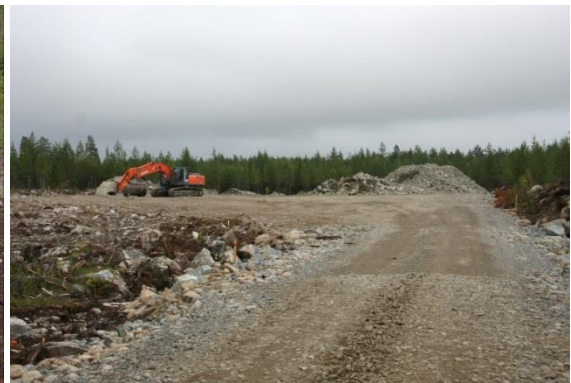
Kuvapari 4-14. Huoltoteiden ja pystytysalueiden rakentamista (kuvat:FCG).
