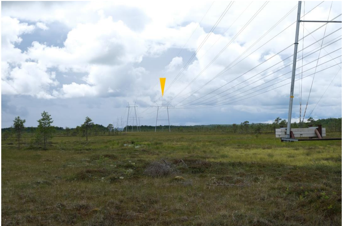
Kuva 8-36. Havainnekuva sähkönsiirtoreitin SVE1A näkymisestä kuvauspisteeltä 3 Paukanevan pitkospuupolulta etelää kohti katsottuna. Vieressä olemassa olevan voimajohdon johtopylväs ja ilmajohdot. Uuden voimajohtopylvään sijainti on osoitettu oranssilla nuolella
