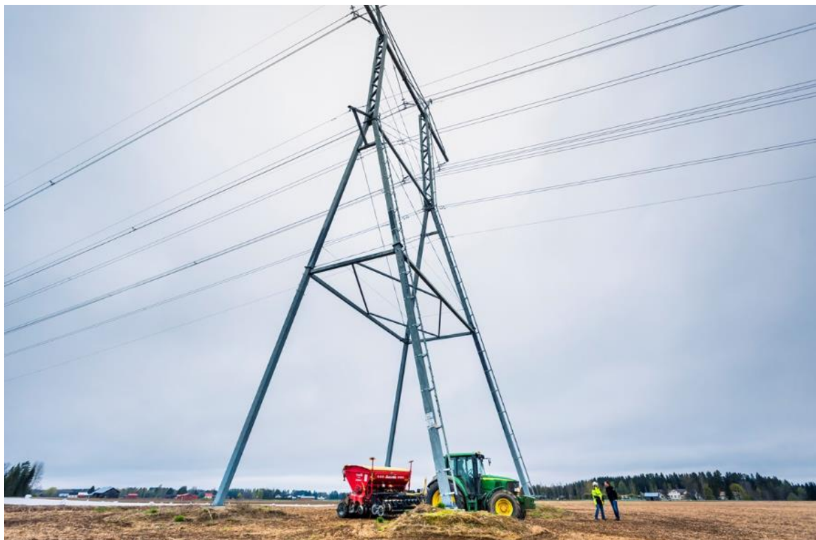
Kuva 5.8 Esimerkkikuva harustamattomasta peltopylväsmallista, joita on pyrkimys käyttää peltoalueilla. Peltopylväsmallilla voidaan minimoida maanviljelylle aiheutuvat haitat ja parantaa työturvallisuutta (kuva: Fingrid Oyj 2025).
