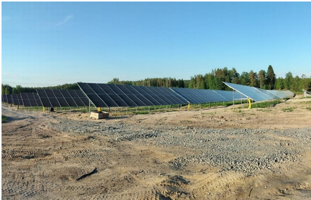
Kuva 5.14 Esimerkki rakenteilla olevasta aurinkovoima-alueesta. Kuvassa Kitusenkulman aurinkovoima-alue Virroilla. (Kuva: FCG)
