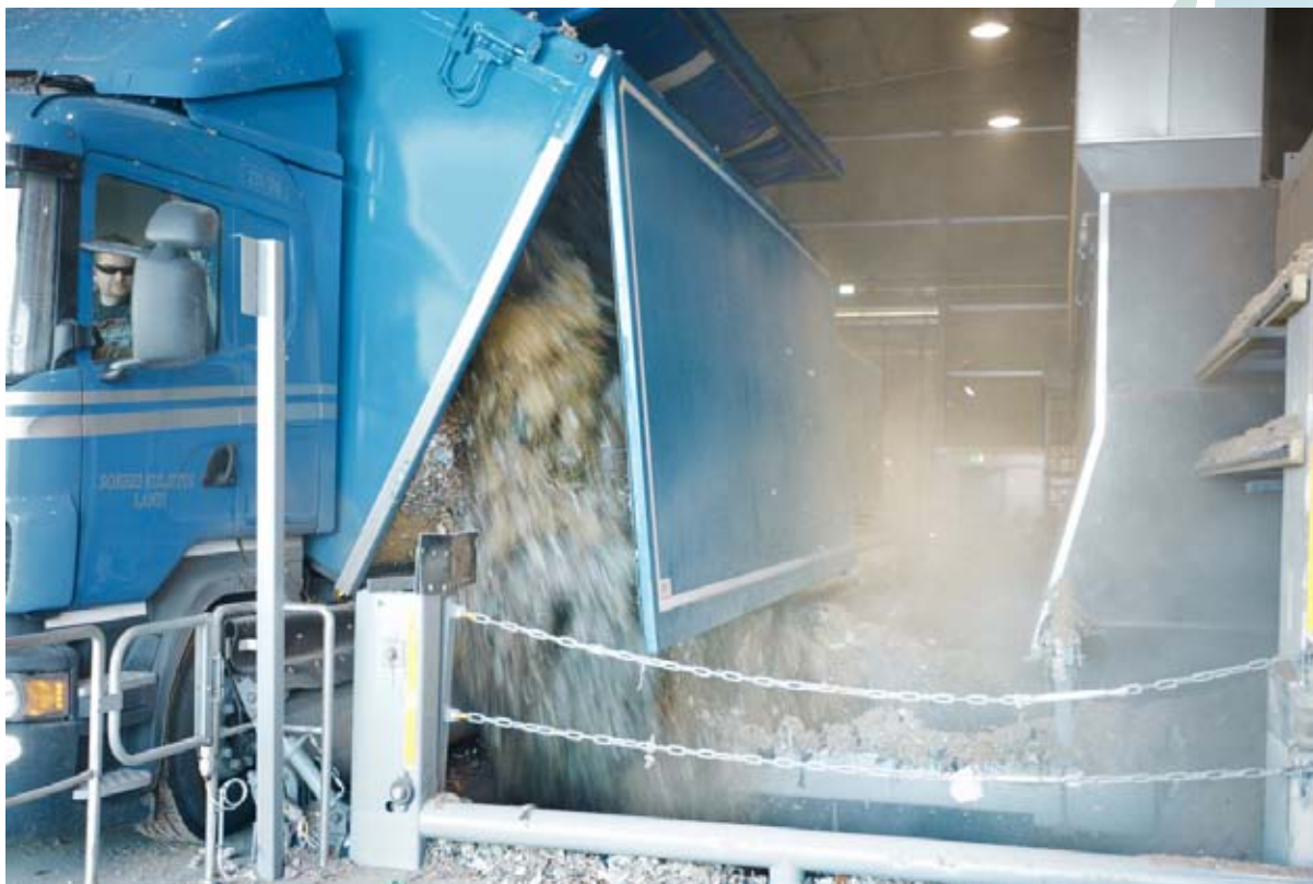
Kuva 2. Kymijärvi II:n kierrätyspolttoainekuorma puretaan polttoaineen vastaanotossa.
