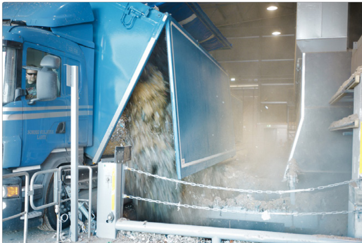
Kuva 2. Kymijärvi II:n kierrätyspolttoainekuorma puretaan polttoaineen vastaanotossa.
