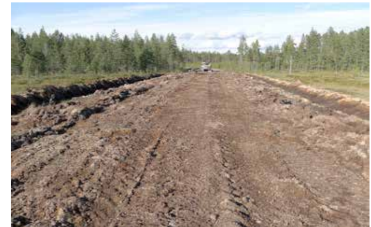
Kuva 11. Iso-Tervapirkon kaakkoispuolelle rakennetaan metsätietä metsä- ja suoalueiden lävitse.
