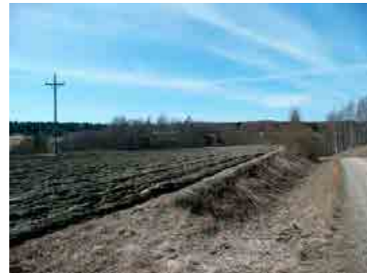
Kuva 6. Maakaapelin linja Lestijoen itäpuolella (VE1).
