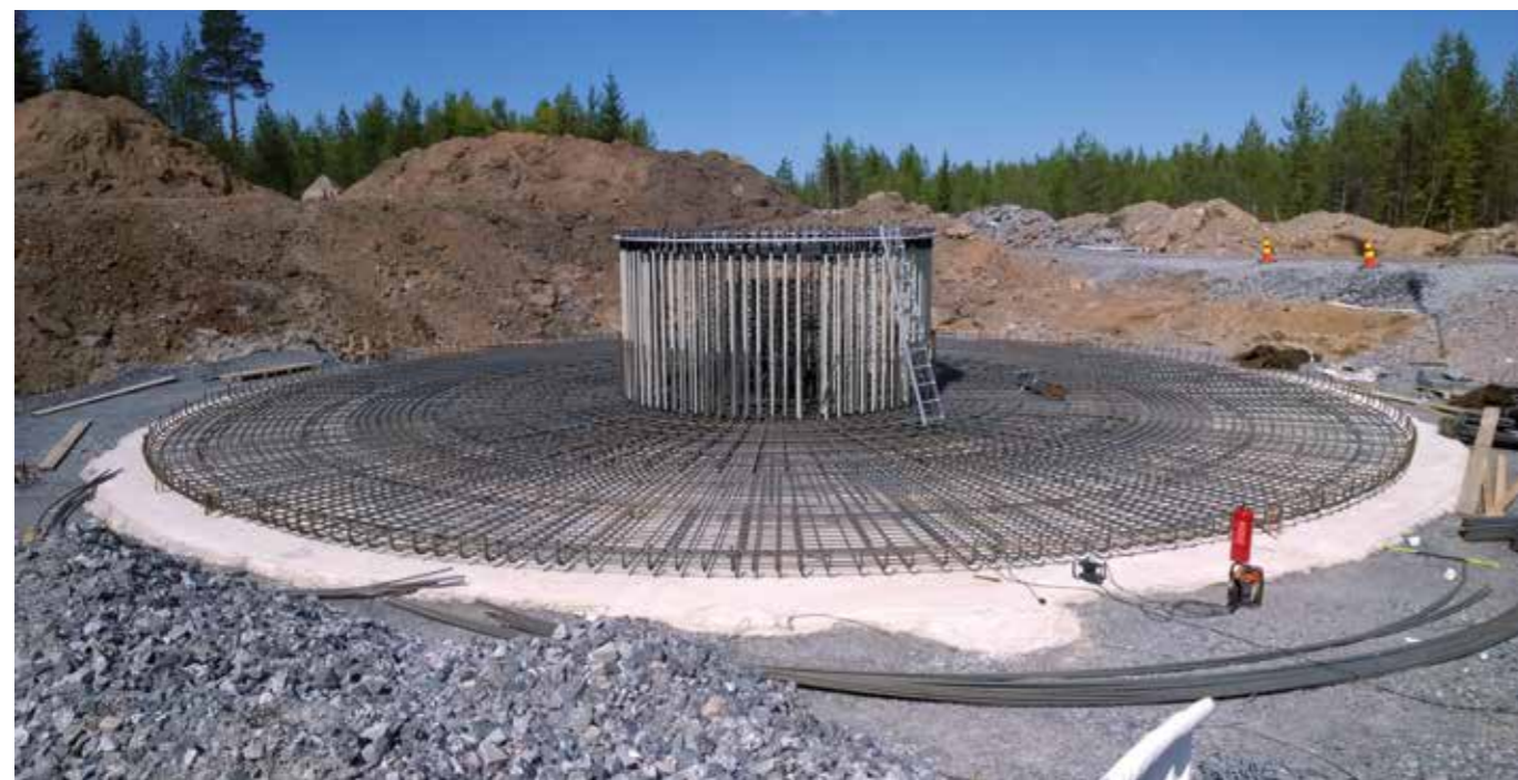
Kuva 10. Maanvarainen teräsbetoniperustus raudoitettuna ennen betonivalua, Mäkikankaan tuulipuisto Pyhäjoki © wpd Finland Oy.
