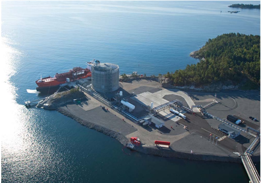
Kuva 6. Esimerkki LNG-terminaalista. AGA:n uusi terminaalit Ruotsin Nynäshamnissa, jossa säiliökapasiteetti on 20 000 kuutiometriä.
