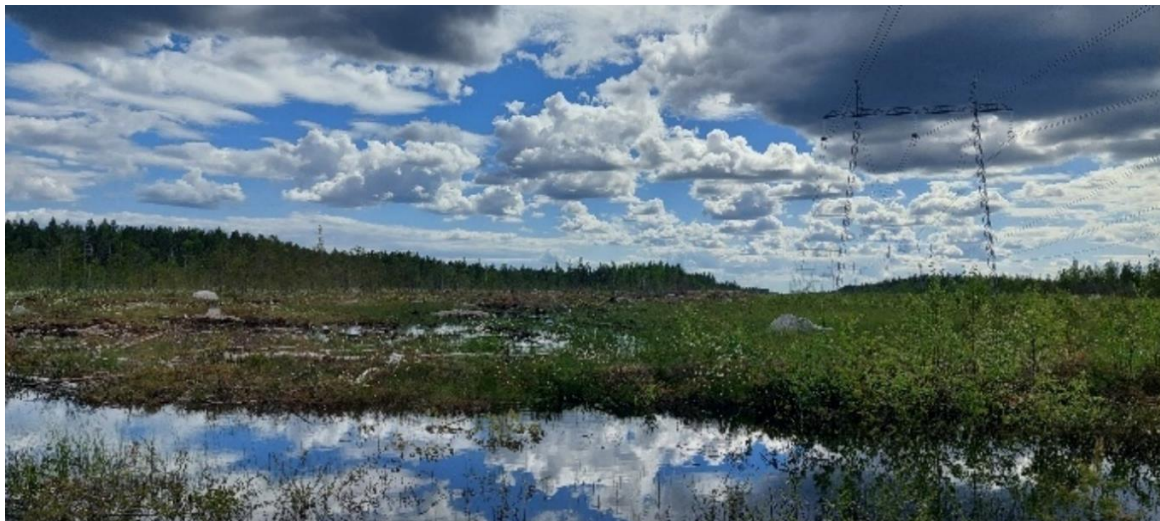
Kuva 15. Alajärvi-Eltonvea 400 kV voimajohdon rakennustyömaan alueella suo on voimakkaasti muuttunut.
