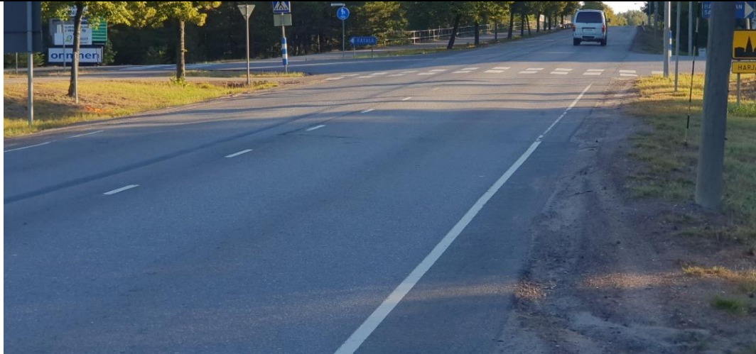
Kuva 13. Ratalankadun liittymä vasemmalle Siltatieltä.
