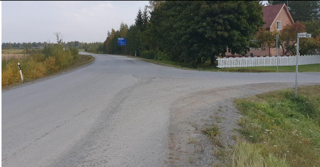
Kuva 8. Näkymä Hiittenkiukaantieltä Torttilan sillalle päin. Oikealla Oikotie.
