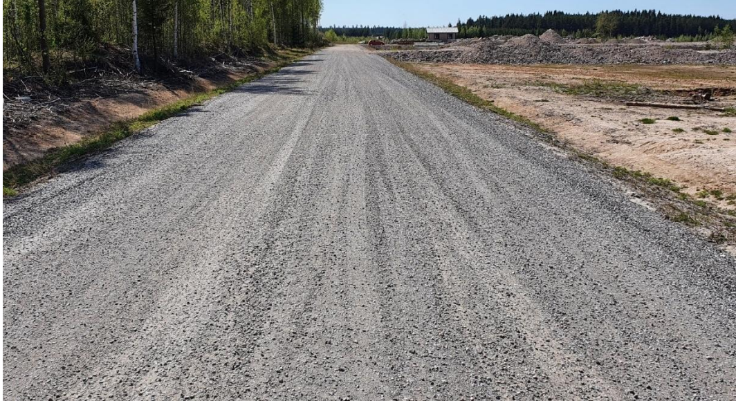
Kuva 15. Yrttisuonkatu kuvattuna Sievarinkadun suunnasta Sievarin kaatopaikan suuntaan.
