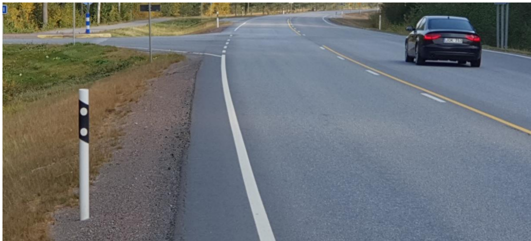
Kuva 12. Näkymä kantatieltä 43 Harjavaltaan päin. Vasemmalla Hiirijärventien risteys.
