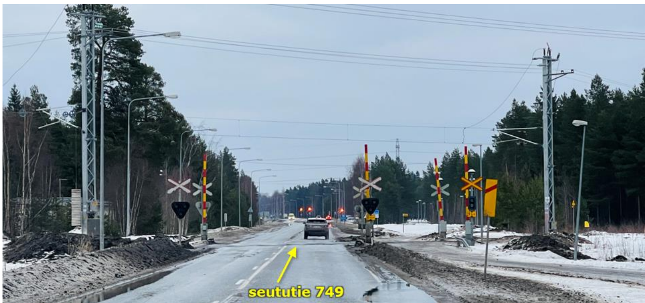
Kuva 6: Kokkolassa seututiellä 749 Varikon tasoristeuksessa on ajojohtimien nostolaitteisto.
