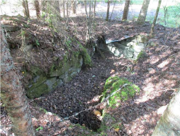
Kohde 23. Torpan perustus, kuvattu luoteeseen.
