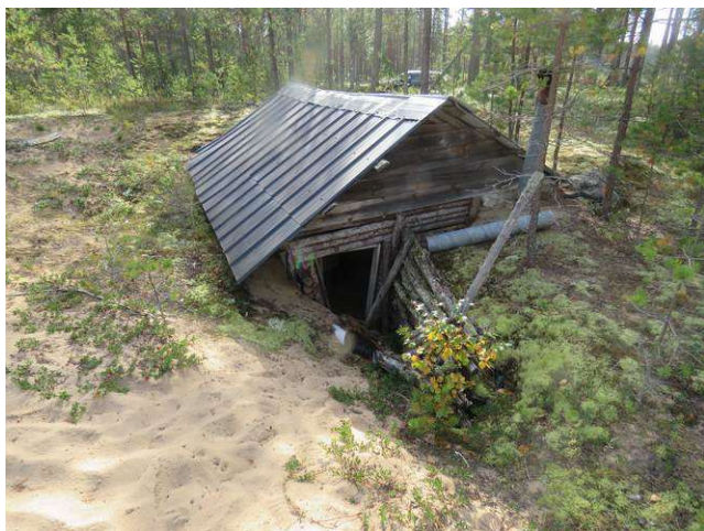
Kuva L 53. Maahan kaivettu suoja Sepänharjulla linjakäytän pohjoispuolella.
