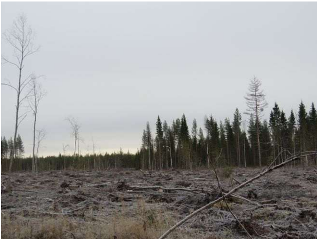
Kuva 21. Voimalinjan VE1 Vitsakangas koillispää Korkia-aholla, pohjoiseen.
