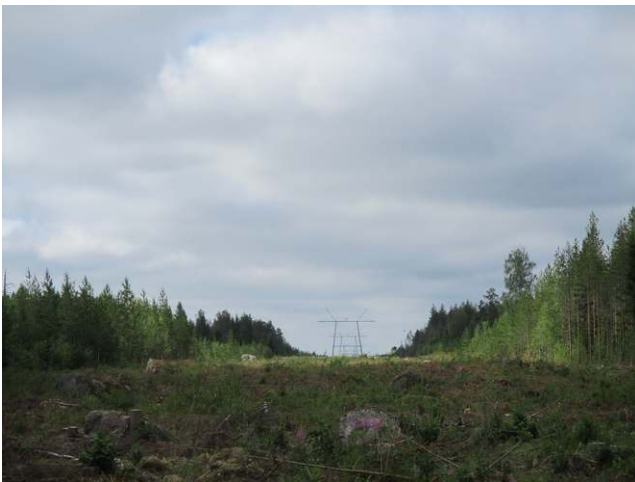
Kuva 22. Uusi sähköaseman paikka kuvattu etelään.
